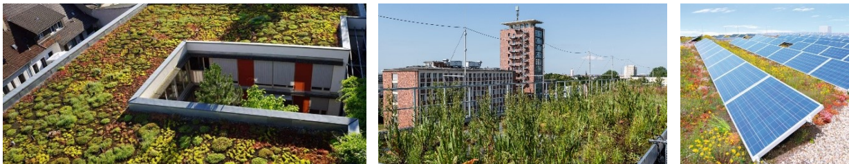
Abbildung 1 verschiedene Dachbegrünungsaufbauten mit und ohne Solaranlagen; Bauverlag BV GmbH, Kozubek & Schatz Bedachungs- und Installations GmbH, Helmholtz-Zentrum für Umweltforschung GmbH - UFZ
