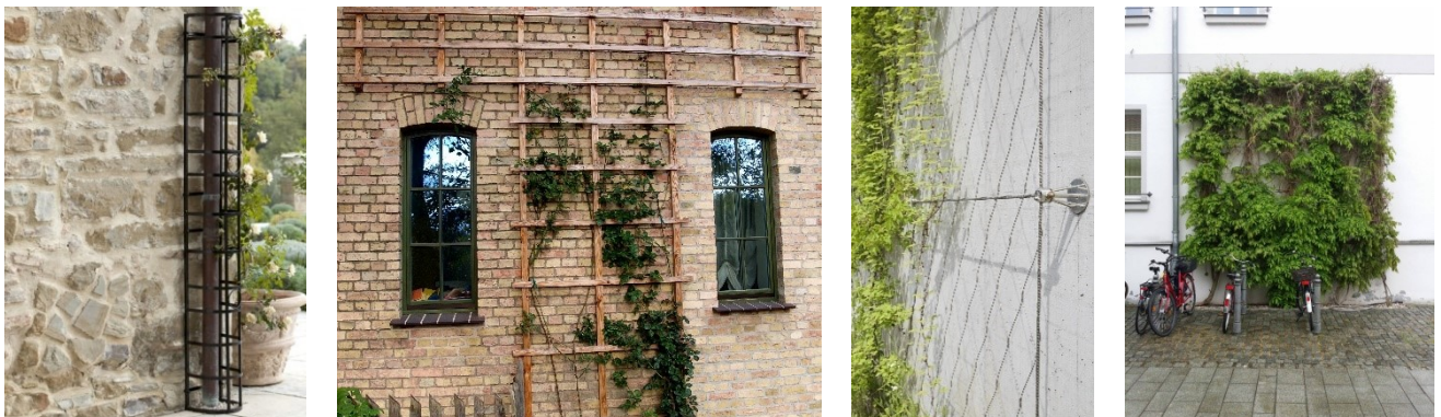
Abbildung 5 v.l.n.r. Spalier für ein Fallrohr, Holzspalier, Drahtsystem, das Ranksystem „verschwindet“ hinter der Begrünung; LOBERON GmbH, Wikipedia, Jakob AG, StadtLand GmbH
