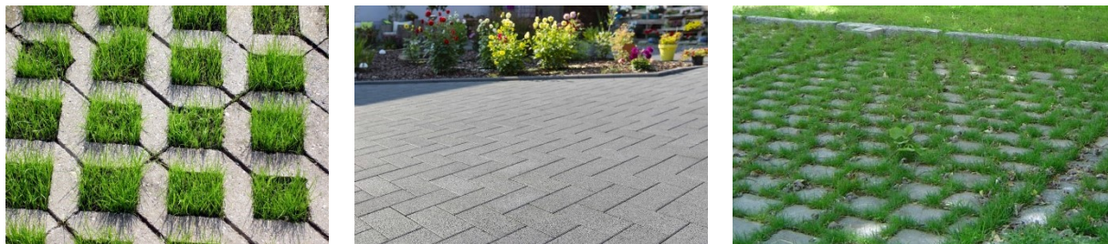
Abbildung 2 l. Rasengitterstein, m. haufporiger Belag, r. Belag mit vergrößertem Fugenraum; Quelle: Kortmann Beton GmbH & Co. KG 2021, KANN GmbH Baustoffwerke 2021, BWL Betonwerk Linden GmbH & Co.KG 2021
