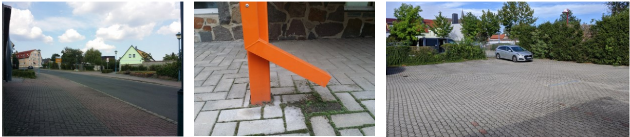
Abbildung 1 versiegelte Flächen in der Kurstadt. Im mittleren Beispiel wird statt auf die nahe Grünanlage oder in eine Speichervorrichtung direkt auf das Pflaster abgeleitet. Quelle: StadtLand GmbH 2019 – 2020
