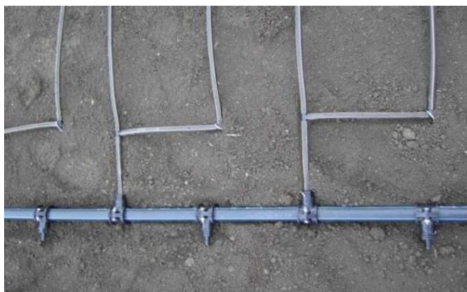
Kosteneinsparung durch einfache Installation der Tröpfchenbewässerung, Uwe Körner GmbH
