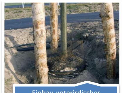
Einbau unterirdischer Bewässerungsschläuche um Wurzelballen
