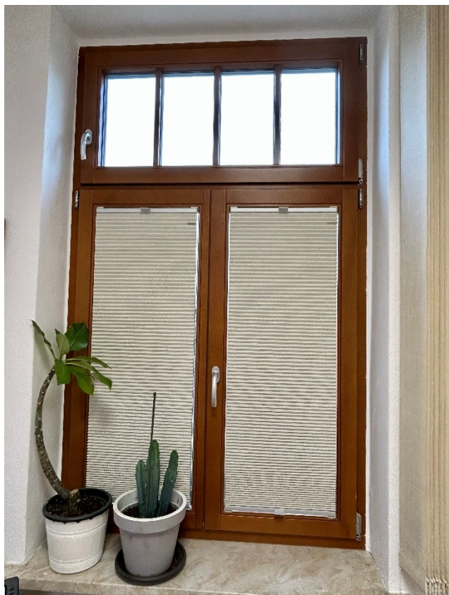
Abbildung 1: Mit hitzereflektierenden Wabenplissees ausgestattete Fenster der Südfassade des Rathauses Eibenstock.
