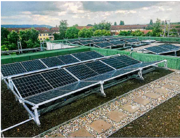
Abbildung 2: Kombination einer Photovoltaikanlage mit extensiver Dachbegrünung (frisch gepflanzt).
