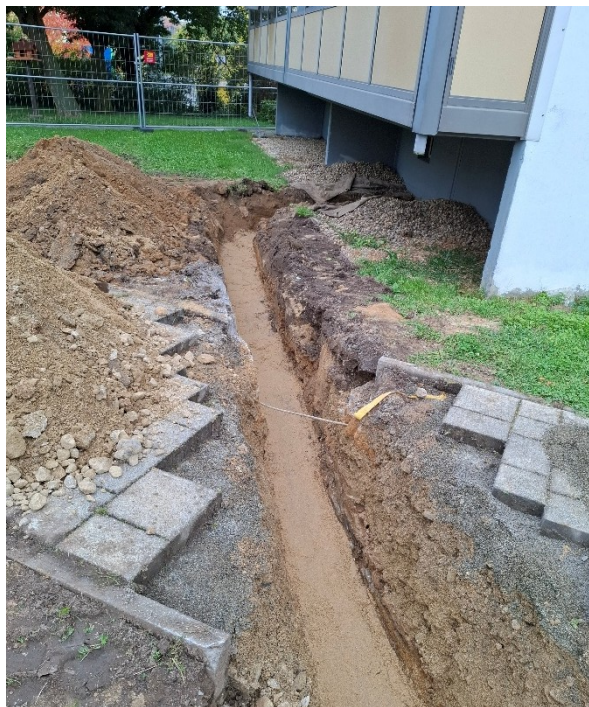
Abbildung 2: Vorbereitung Rohrumbindung (Foto: F. Pusch/LfULG)
